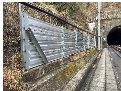
写真3 土砂止め柵改良工
