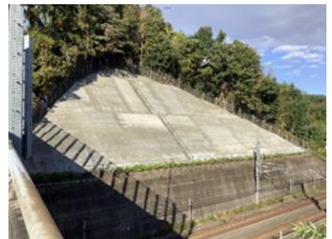
写真1 切土区間の施工（モルタル吹付工）
