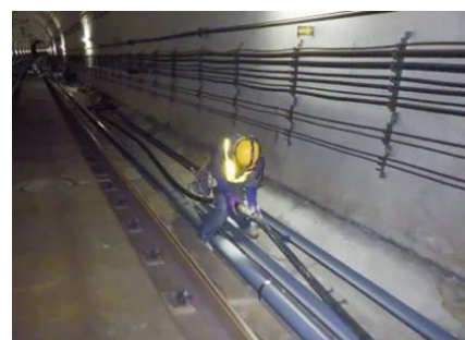
写真5 営業線脇設置の配管状況
