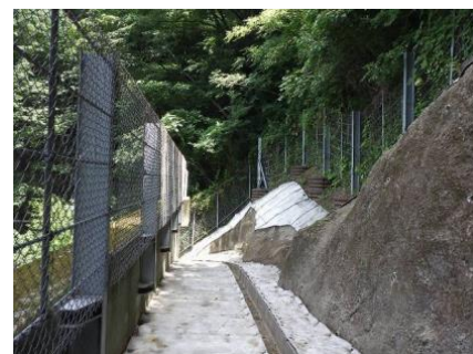
写真4 モルタルシート敷設工
