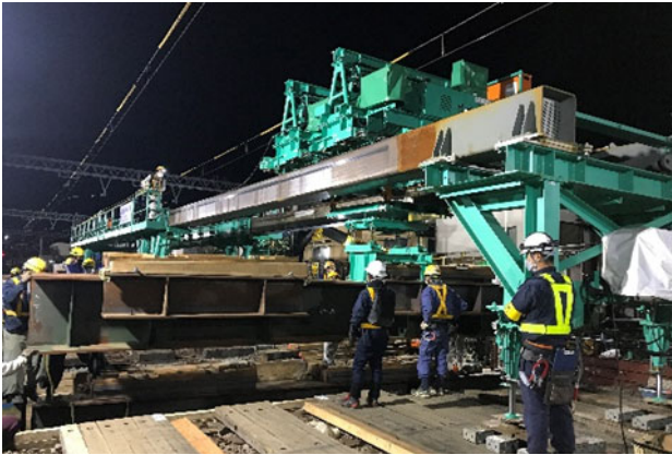
写真-1 かんざし桁の架設状況
