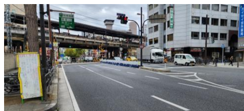
図-6 準備工事施工前（上）、切換工事後（下）
