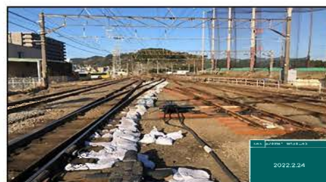
写真-2 乗越分岐器組立状況
