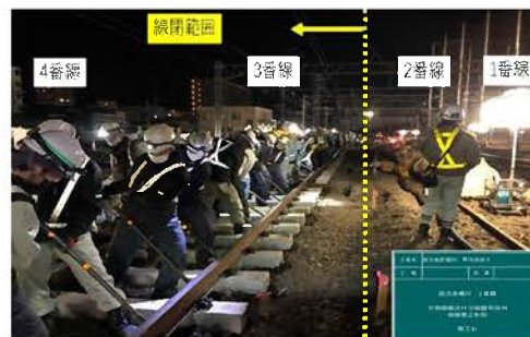
写真-1 準備作業・軌道移動状況
