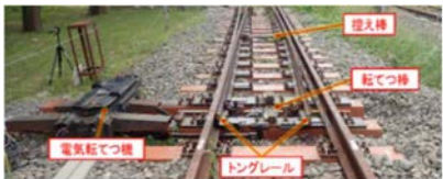
図 1 分岐ポイントと電気転てつ機
