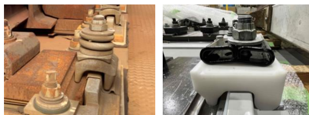
図5 床板締結部構造（左：従来品、右：開発品）
