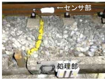
図4 モニタリング装置設置状況
