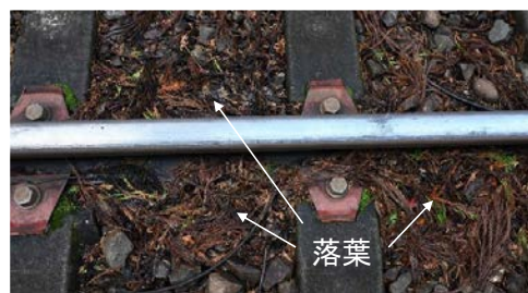
図4 軌道内の状況（12月中旬）
