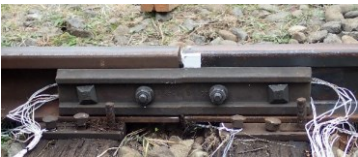
図2 測定対象の継目部
