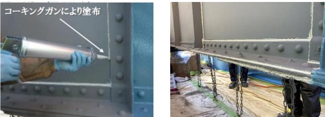
図-10, 11 パテ材の施工
