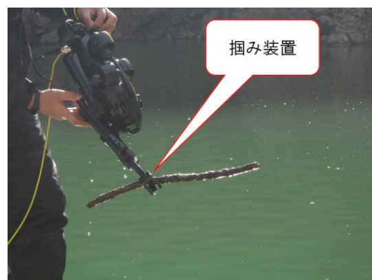
写真 1 掴み装置による支障物除去
