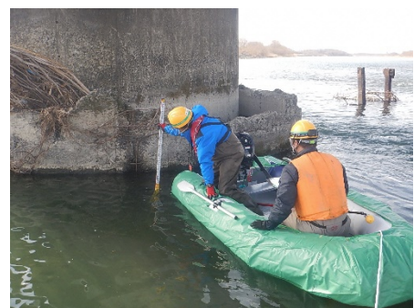
写真2 緊急洗掘点検(ボート)の状況
