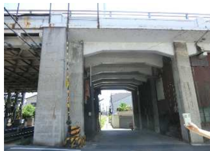
写真-2 桁下状況（1996 年度）
