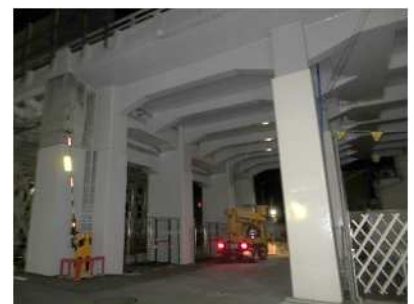
写真-3 点検状況（2017 年度）
