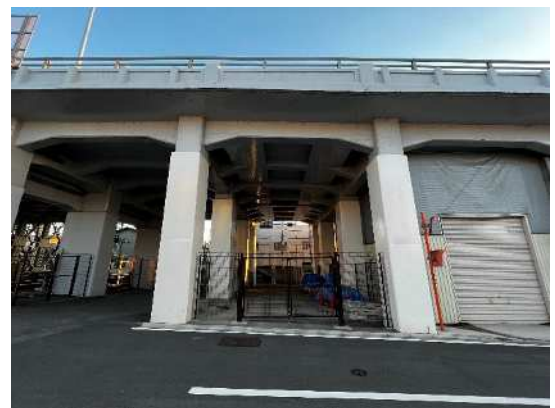
写真-1 桁下状況（2022 年度）
