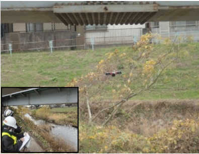
写真-2. 点検状況
