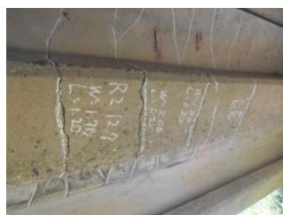
図 2 曲げひび割れ
