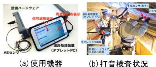
写真1 デジタル打音検査機器や打音検査状況
