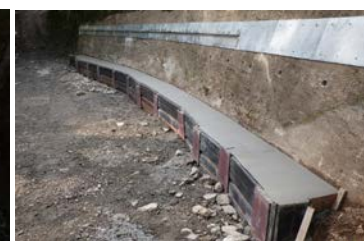
図-4 洗堀対策状況
