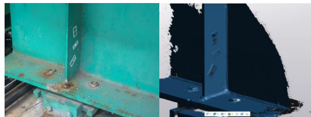
写真 6 現地と計測データ（端支点部廻り）
