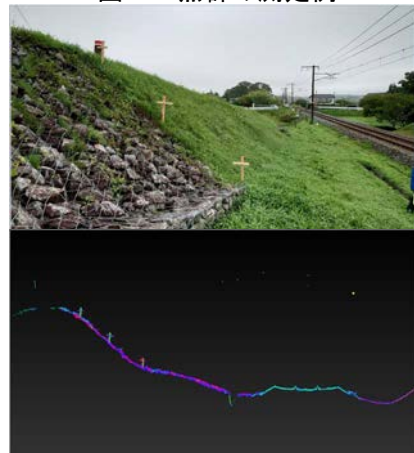
図-2 土工設備における測定
