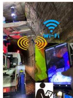
図-9 遠隔操作状況
