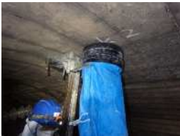
図-5 コア削孔状況
