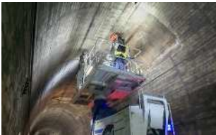
図-4 電磁波レーダー探査状況
