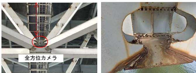
全方位カメラによる点検状況
