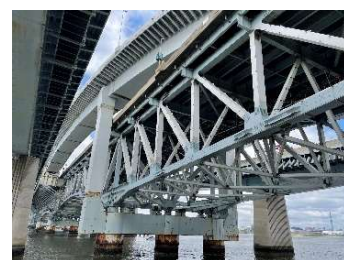
図-1 7 径間ゲルバートラス橋
