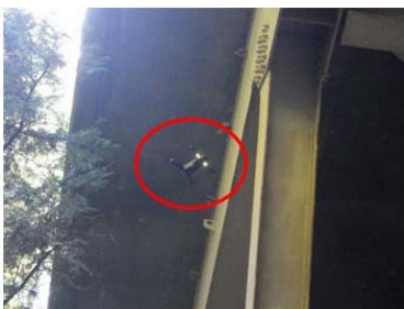
写真-3 張出床版下面撮影
