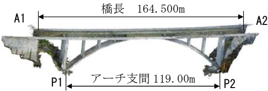
写真-1 橋梁全景
