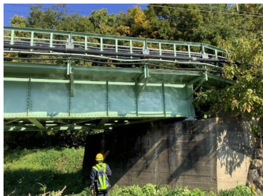
写真1 橋りょう検査風景
