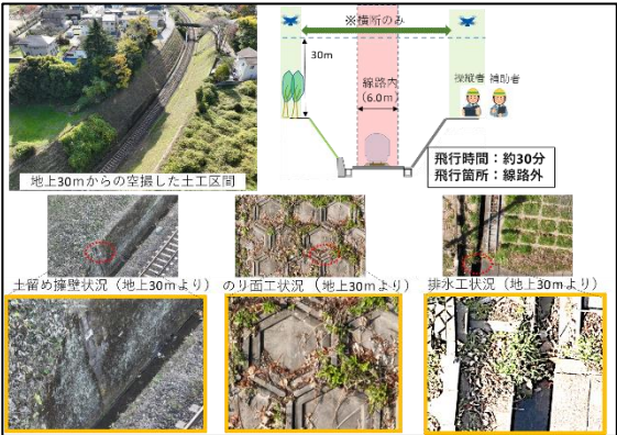
図3 土工区間の検査状況
