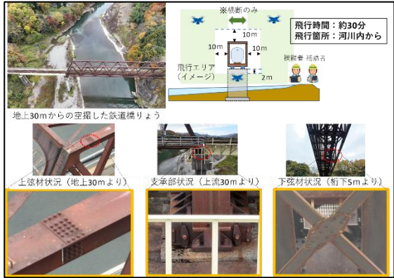
図2 橋りょう区間の検査状況
