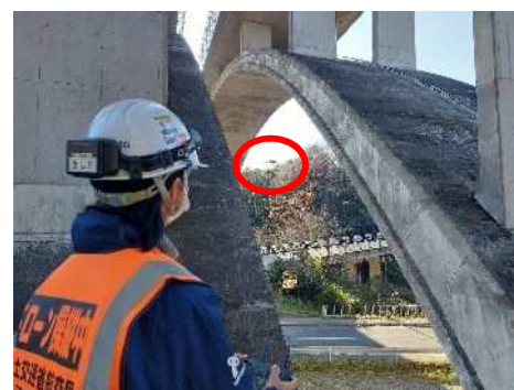
写真-1 ドローン点検状況
