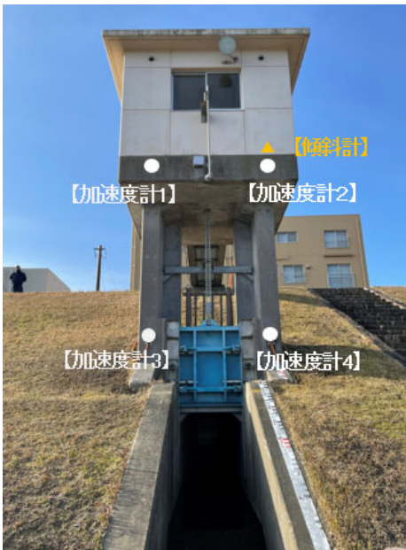
写真-1 計測機器の設置位置
