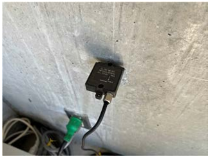
写真-3 傾斜計設置状況
