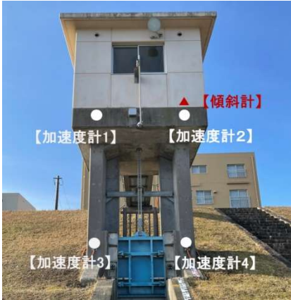
写真-1 対象施設/機器設置状況
