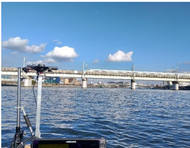
図-1 山陽新幹線神崎川橋梁
