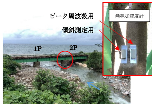
写真-3 無線加速度計設置状況
