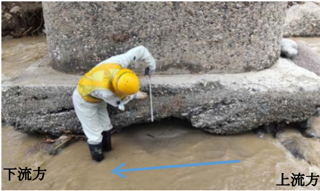
写真-2 豪雨後現場調査状況
