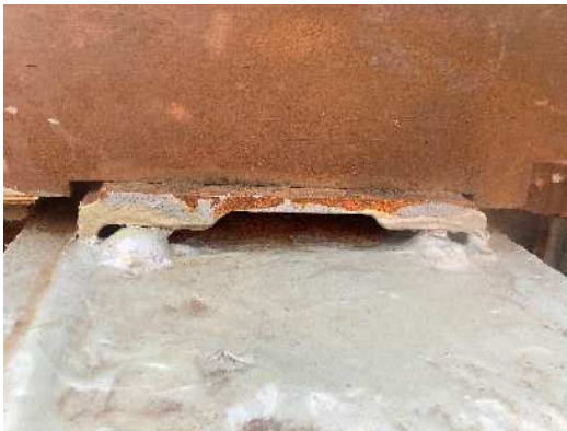
図-5 溝型補強部材切断面
