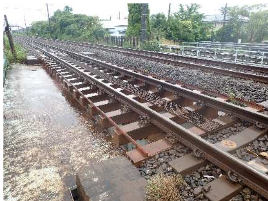
図-1 A 橋りょう全景
