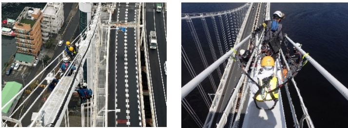
写真-1 ロープにてアクセスする技術を活用した軸力計測状況
