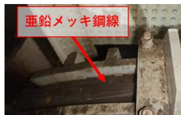
写真-2 主塔内部状況
