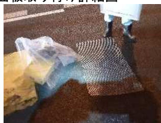
写真-2 撤去した表面板
