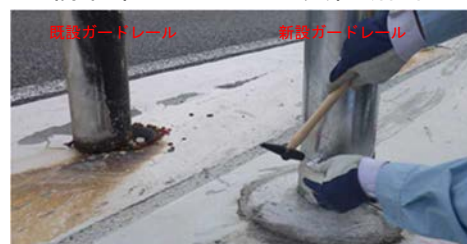
写-1 ガードレール支柱腐食検査
