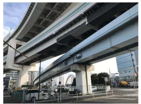
写真-1. 足場設置前の状況
