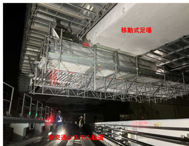
写真-3. 軌道上空の移動式足場運用状況
