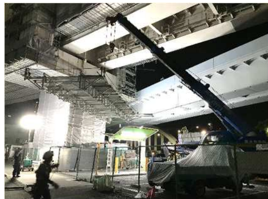
写真-2. ラフタークレーンによる設置状況
