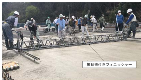
写真-1 振動機付きフィニッシャー
