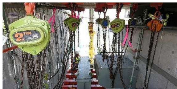
写真-1 吊り上げ装置設置状況
