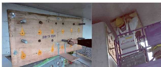
図-7 モデル製作を用いたアンカー位置確認例
