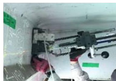
写真-4 斜め削孔状況
