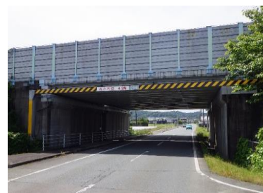
写真-3 各和橋全景
