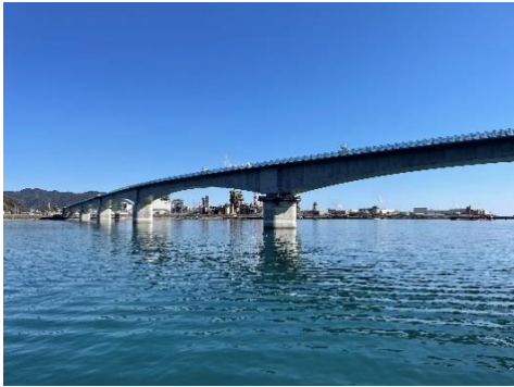
写真-1 橋梁全景
