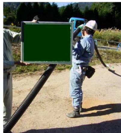
写真－1 山なりの PE シース内で PC 鋼材を往復する状況
