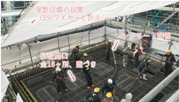
写真-4 コンクリート打設状況
