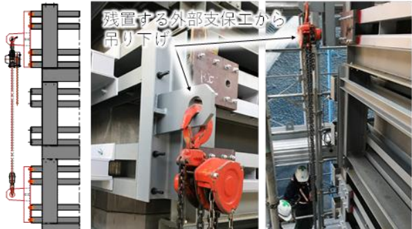
写真-5 外部支保工解体状況
