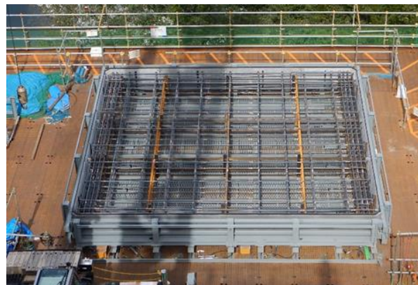
写真-2 プレファブ化完了後の状況
