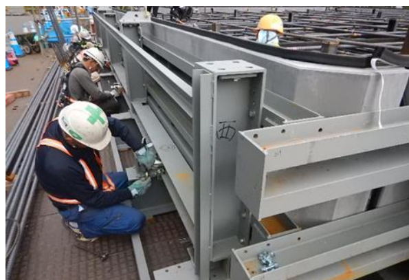
写真-1 水圧ジャッキを用いた部材設置状況
