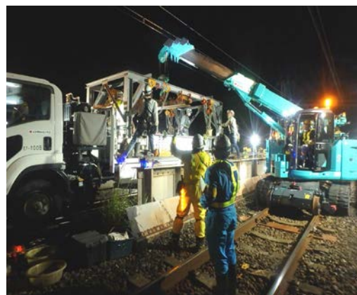
写真-3 軌陸クレーンによる吊り架台設置
