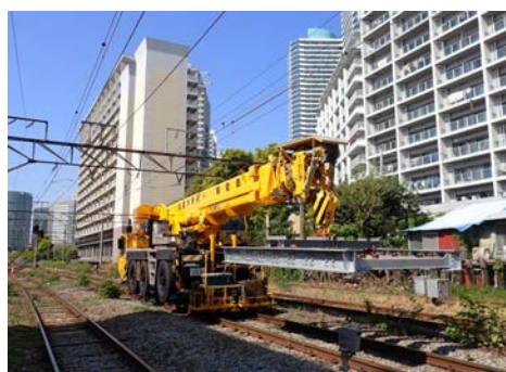
写真-1 50 t 軌陸クレーンによる運搬
