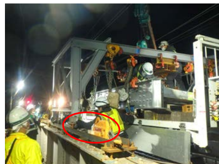
写真-4 軌条設備とチルトタンク・チルホール
