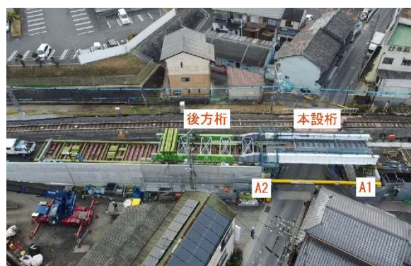
写真-1 送り出し完了
