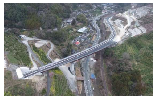
写真-2 郷高架橋（仮称）（令和5年3月）
