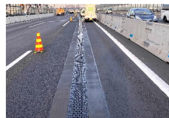
図-7 縦目地設置状況
