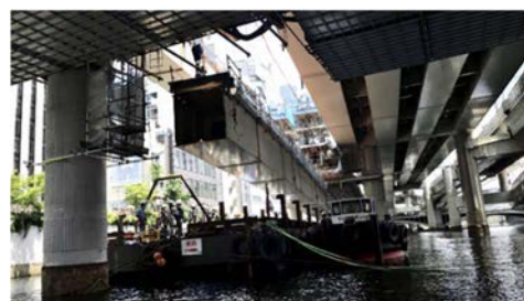
写真-1 主桁降下状況
