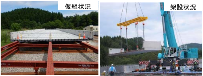
写真-2 壁高欄一体型施工
