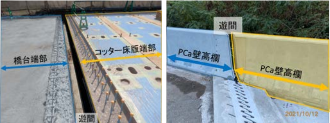
写真-4 端部のプレキャスト化
