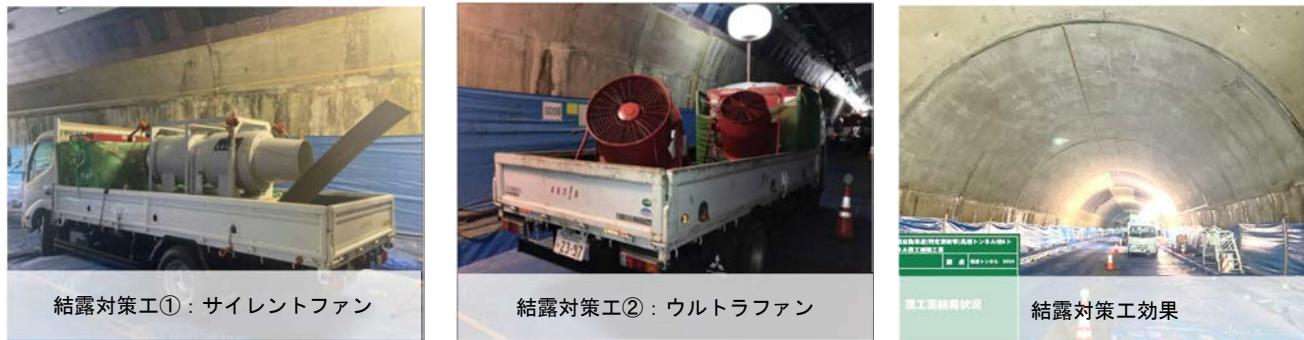
写真-3 結露対策工①～②と結露対策工効果
