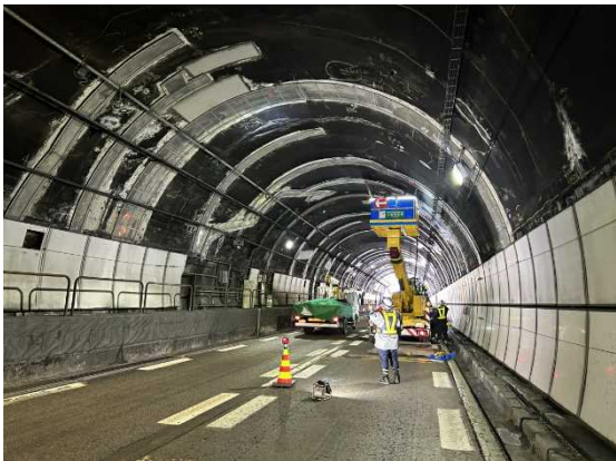
図-1 背面空洞注入状況
